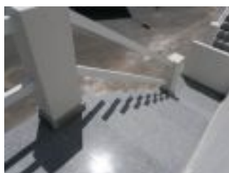
ESCALERA DE ENTRADA
